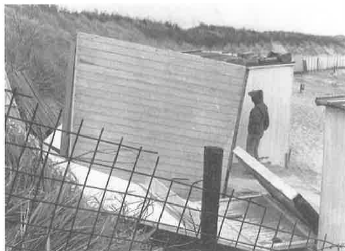
De vraag luidt: de strandhuisjes zijn zwaar beschadigd door de storm. In welk jaar was dit?
