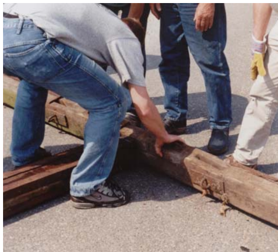
Het in elkaar zetten van de stelling luistert nauw.
