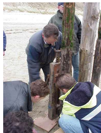
Met een kelderwind worden de palen uit de grond getrokken.
